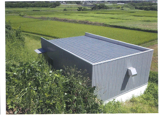
南阿蘇水力発電所建屋。防音性が高く、近くでも発電時の音はあまり聞こえてこない。
